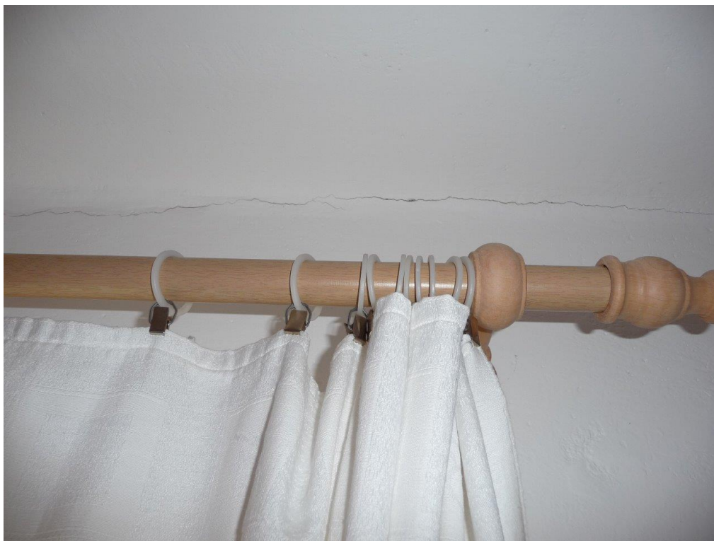
Foto č.78 – Kuchyně – trhlina nad oknem - detail
