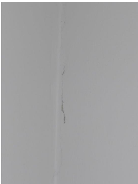
Foto č. 71 – Schodiště - svislá trhlina podél okna - detail
