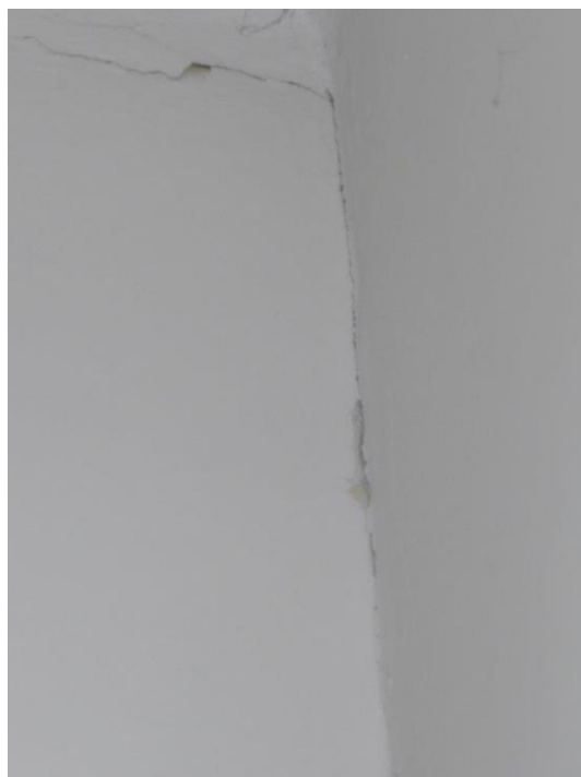
Foto č. 72 – Schodiště – svislá trhlina podél okna – detail
