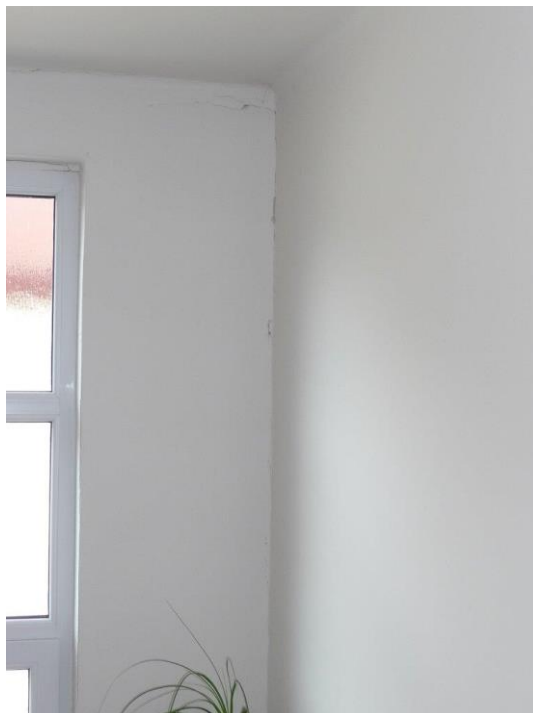
Foto č. 74 – Schodiště – trhlina podél okna vcelku
