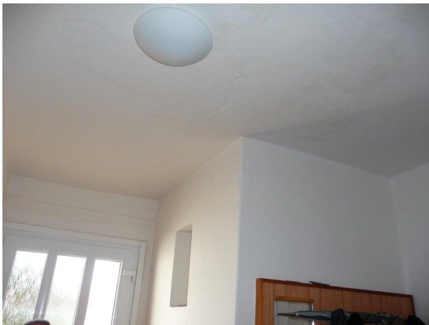
Foto č. 66 – Vstupní dveře – trhlina nad vstupem, odloupaná omítka na stropě
